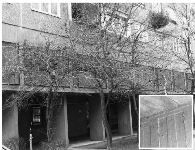
4. ábra Panelház fogadószintje monolit vasbetonból
