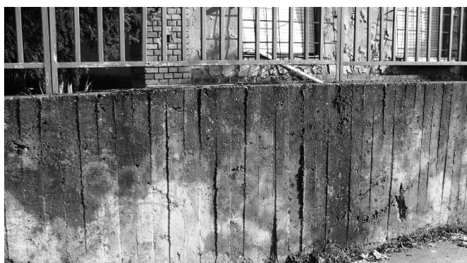
9. ábra Egy társasház betonkerítése
