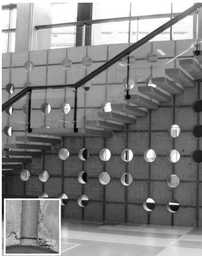
6. ábra Beltéri betonfelületek, SOTE
