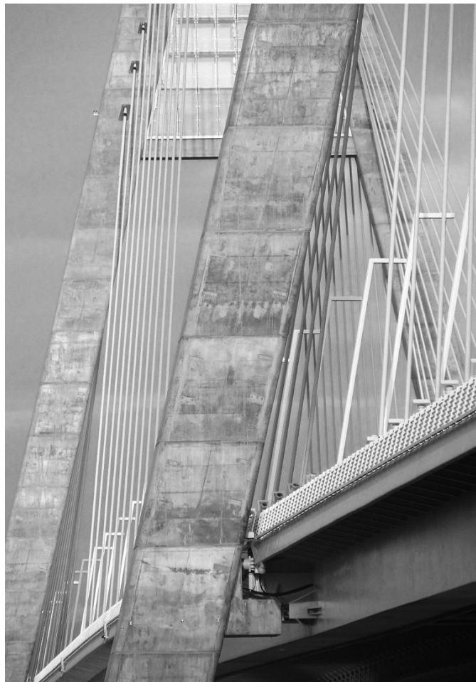
8. ábra Beton hídpillérek, Megyeri híd
