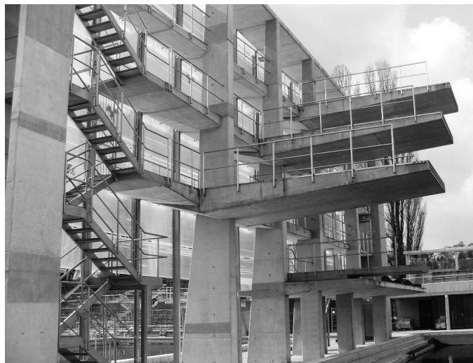
7. ábra Ugrótorony látszóbeton felülete, Sportuszoda
