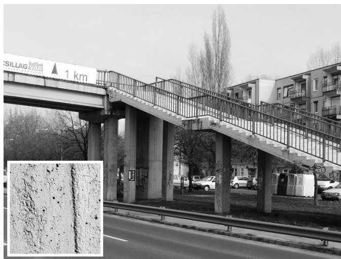
5. ábra Vasbeton oszlopok egy gyalogos felüljárónál
