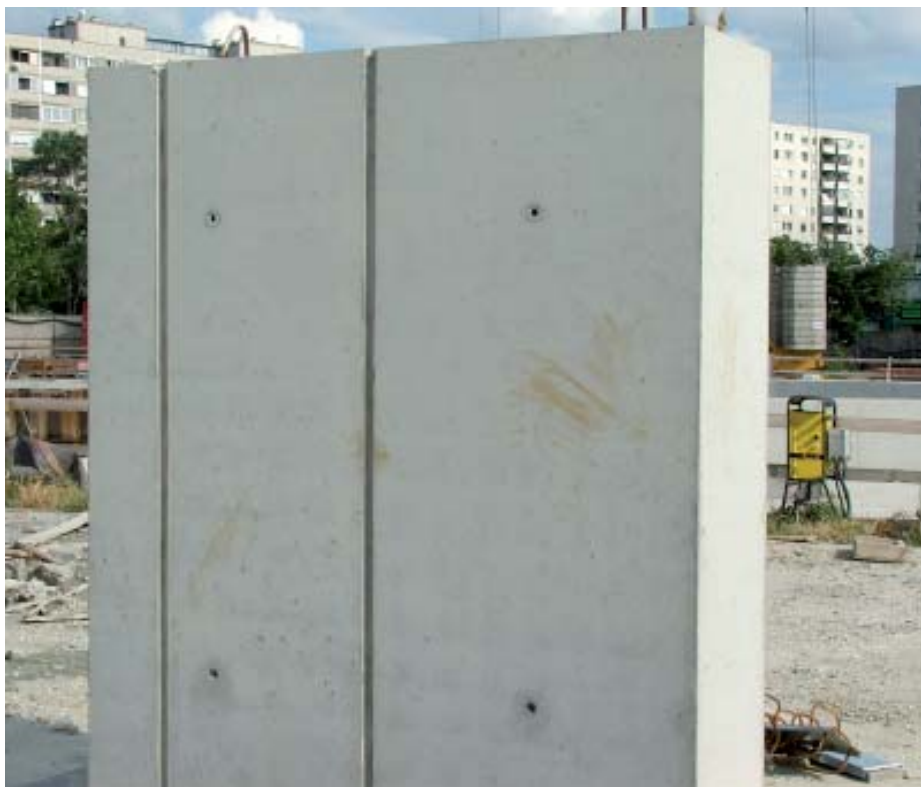
Elkészült próbafelület a 4-es metró építkezésénél
