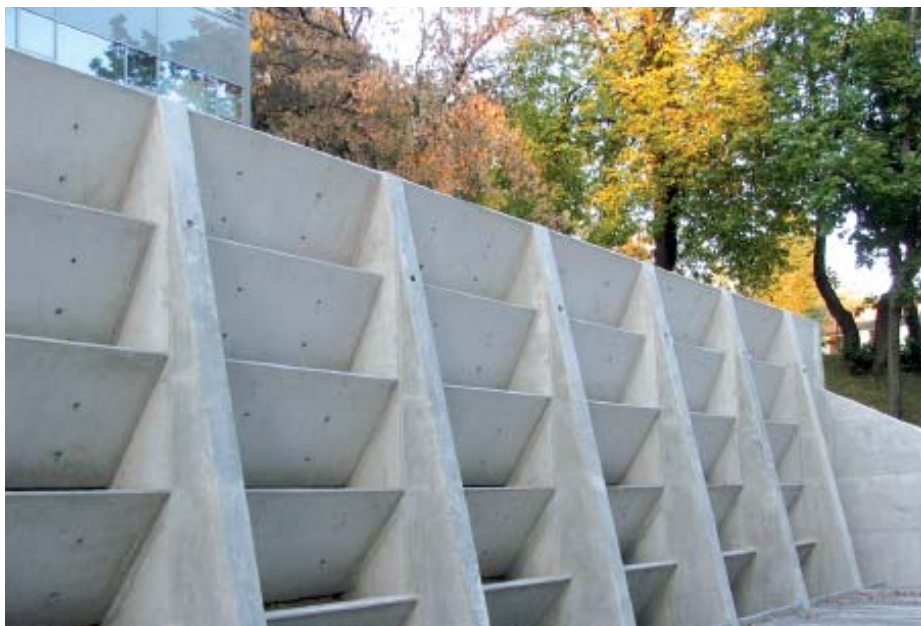
Monolit vasbeton támfal (Szent Margit Gimnázium)
