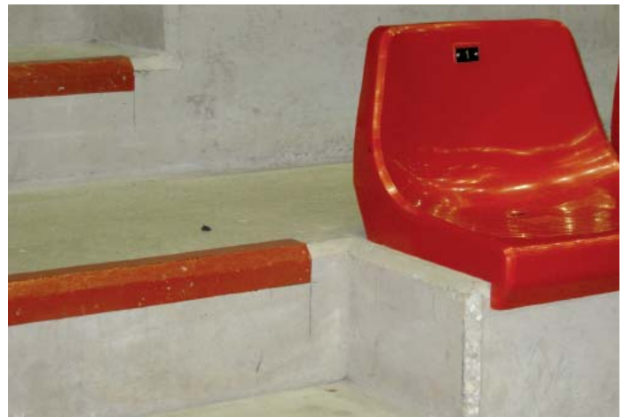
5. kép Lelőtó lépcsőinek elkészült élsarkítása (Budaörs, Sportcentrum)
